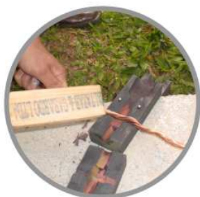
a) Limpar os condutores para garantir uma melhor durabilidade da solda;
