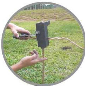
b) Posicionar o molde e inserir a massa para vedação do mesmo;
