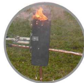
f) Após o término da solda, abrir a tampa do molde e aguardar 30 segundos para retirar o mesmo.
