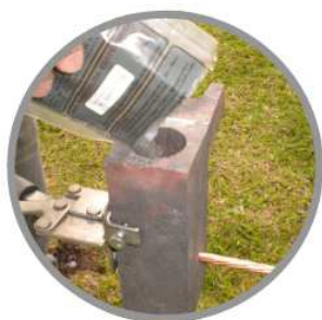
d) Agitar o cartucho antes de inserir o pó no molde. Despejar o pó de ignição deixando um rastilho na borda para facilitar o acendimento;
