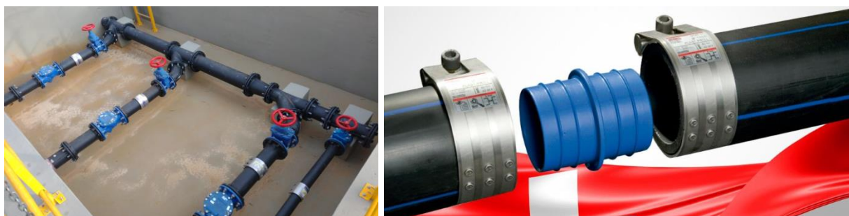
Figura 8 – Medidor de Vazão em caixa enterrada
