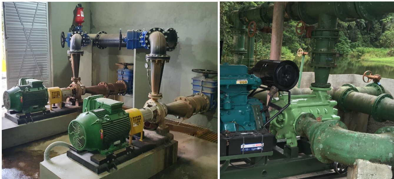
Figura 4 – Redução Excêntrica.
