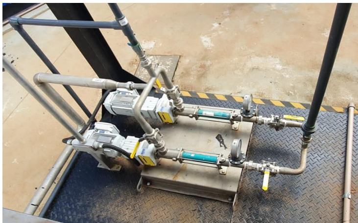
Figura 5 – Bombas com conexão roscada.
