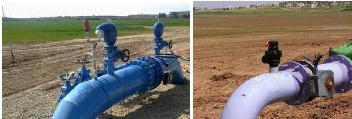
Figura 6 - Válvulas Ventosas
